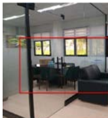
Local de instalação item 3
