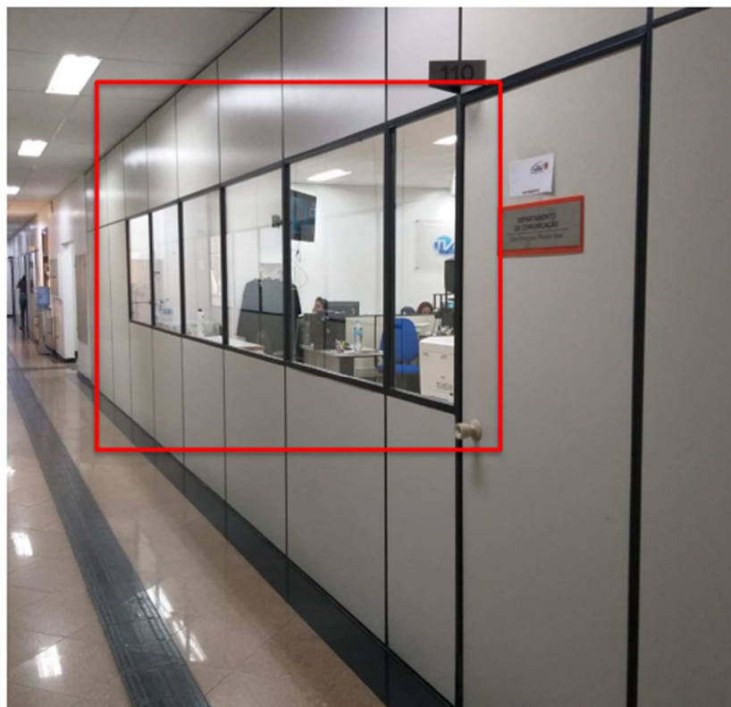
Local de instalação itens 1 e 2
